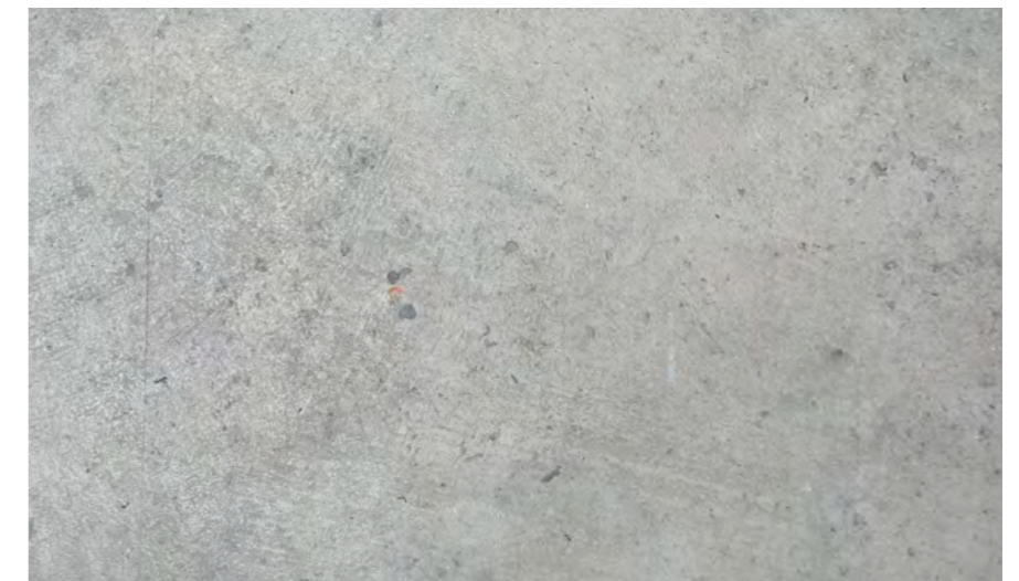
Sokkel i rå beton
