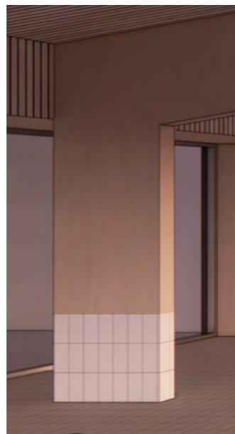
Ny hal Høj sokkel planforsænkede fliser
